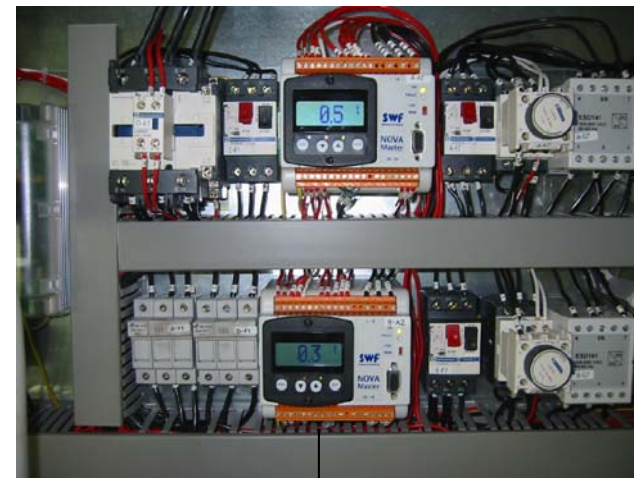
Applicazione NovaMaster nel quadro elettrico
