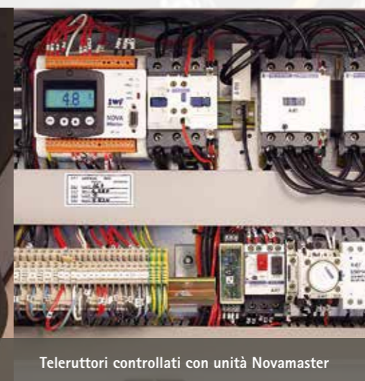
Quadro elettrico in acciaio inossidabile
