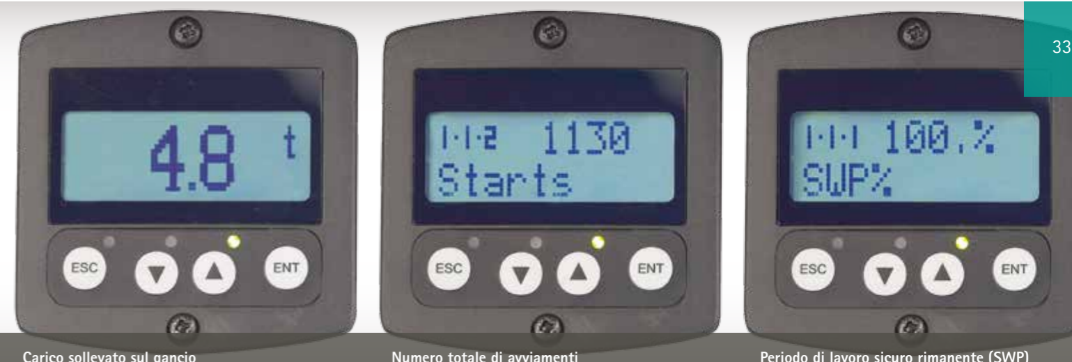
Carico sollevato sul gancio
